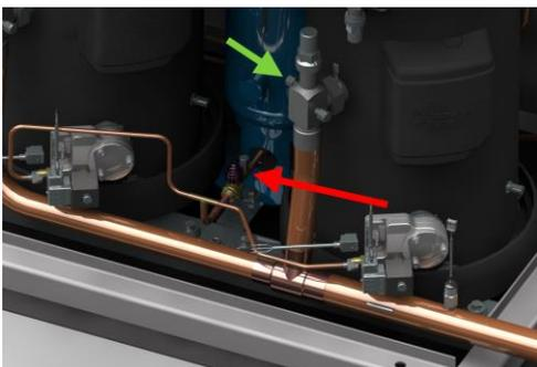
Figure 34 : Ports de service pour la charge en huile
